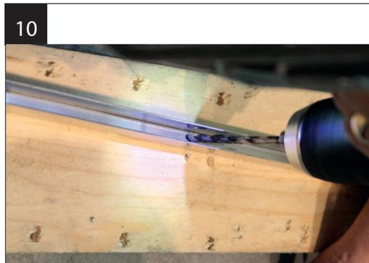
Bohren Sie das Profil mit dem Metallbohrer vor. Empfohlene Bohrlochabstände liegen zwischen 200 bis 300 mm. Achten Sie darauf, dass sich oben und unten ein Bohrloch je nahe am Profilende befindet.
