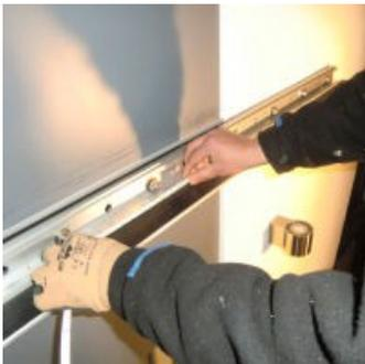
2. Stecker am Lichtband anschließen und Funktion überprüfen.
