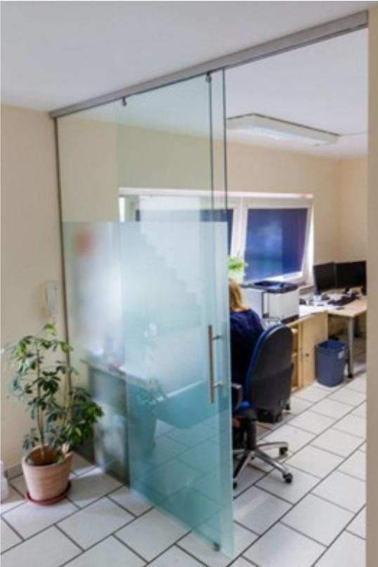
Die Schiebetür Mercato wird mit einer leichten, formschönen Aluminium-Laufschiene befestigt. Das System ermöglicht eine vor der Wand laufende 1- oder 2-flügelige Ausführung. Die Schiebetür kann mit Glasfestteilen kombiniert und so zu einem Raumtrennwandsystem ausgebaut werden.
