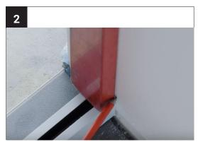
Legen Sie eine Wasserwaage bündig am Bodenprofil an und zeichnen Sie die Basislinien für die seitlichen Profile und das Deckenprofil an Wand und Decke an.
