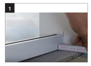
Legen Sie das Bodenprofil auf den Fußboden und zeichnen Sie den gewünschten Seitenabstand an.
