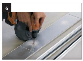
Bohren Sie die markierten Stellen. Verwenden Sie den für Ihren Untergrund passenden Bohrer.
