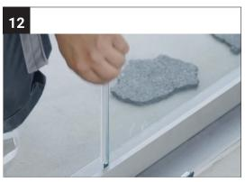
Schieben Sie das H-Profil oder die Kunststoffdichtung auf die freie Glaskante der Scheibe 1.
