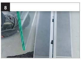
Legen Sie ca. alle 25 cm einen Verglasungsklotz in das Bodenprofil, damit das Glas nicht auf dem Profil aufliegt.
