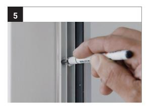
Halten Sie das Profil an die Basislinie und makieren Sie die Bohrlöcher.
