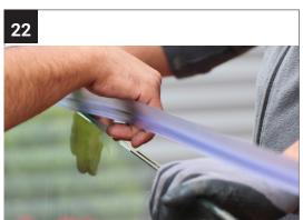
Sofern Sie eine Wandanschluss-Dichtung verwenden, schieben Sie diese nun aufs Glas. Beachten Sie, dass die Lippe nach oben zeigt.
