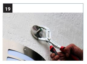
Schrauben Sie die Wandteller mit einer Greifzange auf die Gewindestangen.
