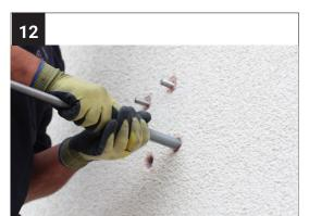
Schieben Sie die Siebhülsen in die Bohrlöcher.
