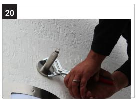
Schrauben Sie zuerst das untere und dann das obere Verbindungsgelenk des Glashalters an.
