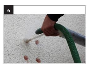
Entfernen Sie den Bohrstaub mit einer Luftpumpe aus den Bohrlöchern. Das sorgt für einen verbesserten Haftverbund.
