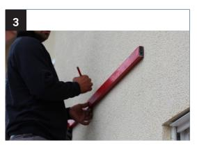
Ermitteln Sie die Haustürmitte und zeichnen ca. 20 cm über dem Türrahmen einen ersten Basispunkt an. Richten Sie hier die Wasserwaage aus und zeichnen eine Basislinie an.
