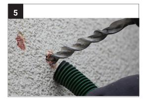
Verwenden Sie den zum Befestigungsmaterial passenden Bohrer. Saugen Sie beim Bohren den Bohrstaub ah
