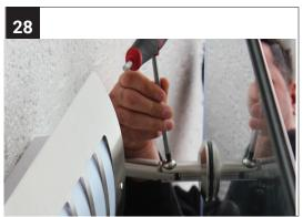
Verschrauben Sie das Verbindungsgelenk mit dem Glashalter.
