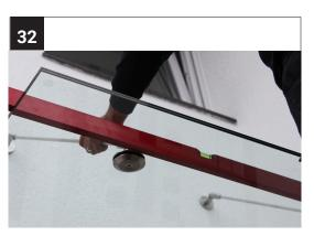
Justieren Sie die Zugstäbe parallel und richten Sie das Vordach mit Hilfe der Wasserwaage aus. Achten Sie besonders darauf, dass Sie die Zugstrebe nicht raus drehen und das Glas damit runter klappt.
