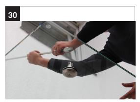
Klappen Sie das Glas hoch, bis Sie mit den vorderen Glashaltern die Zugstäbe erreichen.
