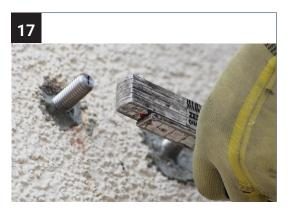
Überprüfen Sie während der Aushärtezeit noch einmal die Abstände der Gewindestangen und richten Sie ggfs. die Stangen passend aus.
