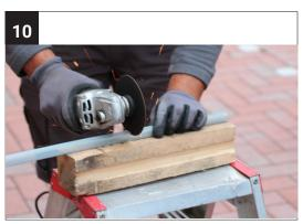
Schieben Sie die Siebhülse ins Bohrloch und markieren den Schnittpunkt. Schneiden Sie die Siebhülsen auf Länge der Bohrlöcher zu.
