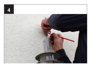
Zeichnen Sie gemäß der Angaben in Ihrer technischen Zeichnung die Bohrlöcher für die unteren Glashalter und die oberen Stange-Wand-Halter an.
