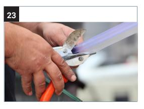
Kürzen Sie die Dichtung mit Hilfe einer Gehrungsschere.
