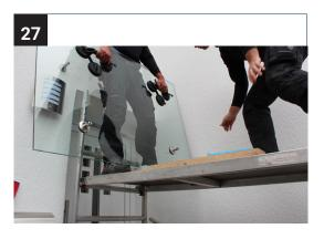
Heben Sie das Glas mit Hilfe von Glassaugern so aufs Gerüst, dass die Glasunterseite zur Wand hin zeigt.
