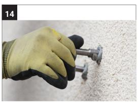
Ziehen Sie die Gewindestangen heraus und füllen Sie den Kleber gleichmäßig ins Bohrloch. Schieben Sie dann die Gewindestangen drehend wieder ins Bohrloch.
