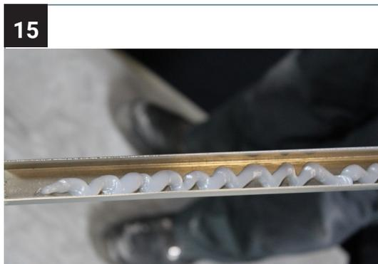
Sofern Sie einen Kantenschutz auf der Glasoberkante verwenden, silikonieren Sie die Innenseite des U-Profils und setzen es dann fest aufs Glas auf.
