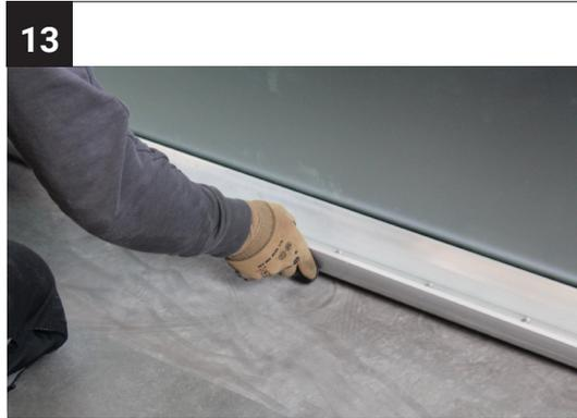
Klipsen Sie die Abdeckprofile auf den Profilkörper und ziehen Sie danach die Schutzfolie von der Abdeckung ab.
