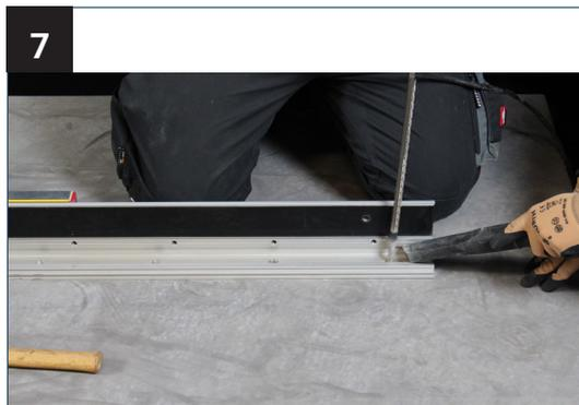
Bohren Sie mit einem Steinbohrer die Löcher ins Fundament.
