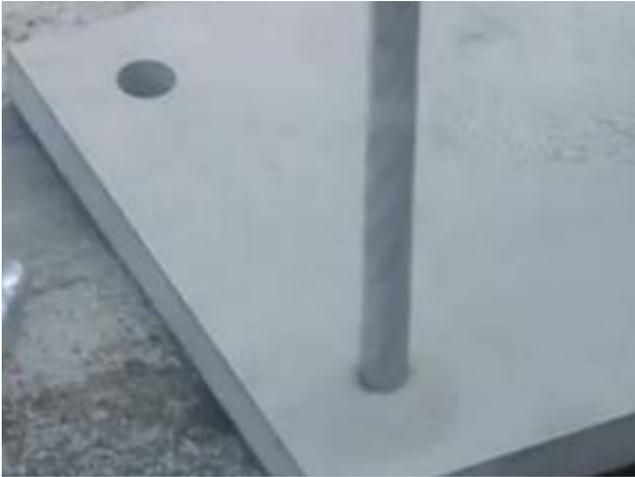
Nach dem Ausrichten die Fußplatten befestigen.
