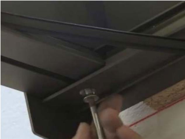
Seitensparren mit Senkkopfschrauben unterhalb der Traverse befestigen.
