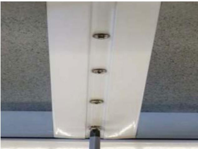
5. Glasstoßunterteil mit den Blechschrauben von unten befestigen, Abstand 50 mm, Schrauben nur handfest anziehen.
