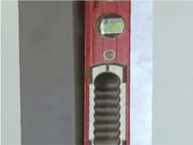
Stützen mit Wasserwaage ausrichten.
