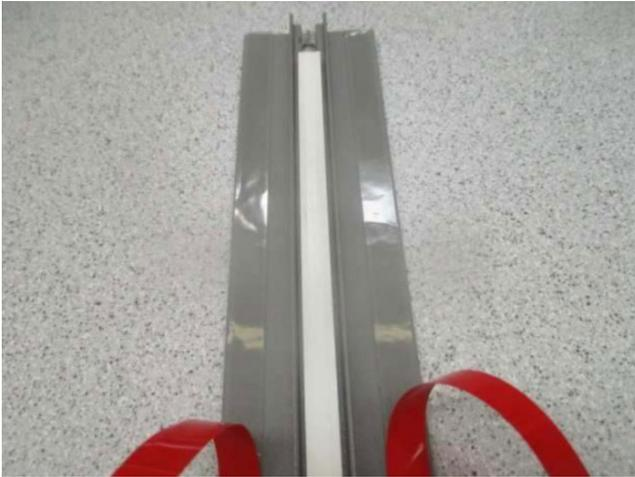
3. Am Glasstoßoberteil, die Klebeschuttfolie beidseitig abziehen und passgenau auf das -unterteil stecken und andrücken.
