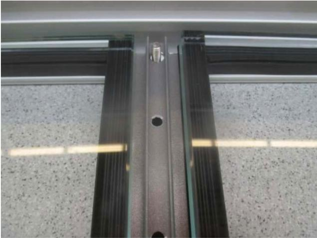
2. Scheiben einlegen, ausrichten und Scheibenkanten im Glasstoßbereich mit Aceton reinigen.
