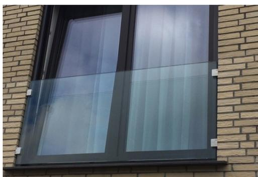
Die Absturz­sicherung am Fenster, auch „französischer Balkon“ genannt, wird aus Verbund­sicherheitsglas mit bauamtlicher Zulassung gefertigt. Dabei ist die Glasgestaltung wählbar zwischen Klarglas und blickdichtem Glas, beispielsweise satiniert oder farbig. Fensterbrüstungen werden nach Kundenmaß individuell angefertigt. Die Maximalbreite beträgt 250 cm, die Maximalhöhe 130 cm.
