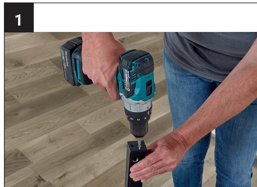
Verwenden Sie die beiliegenden Schrauben in den 2 äußeren Löchern. Kleben Sie jeweils einen Gummistreifen auf die Glasaufstandsfläche.
