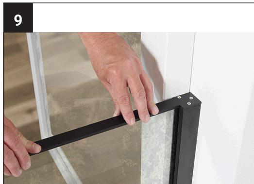
Ein optional mitgeliefertes Kantenschutzprofil wird mit Silikon auf der Glasscheibe verklebt.
