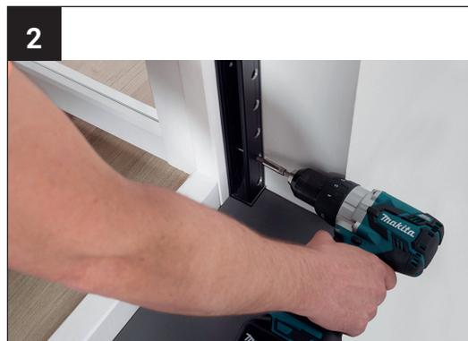
Das Profil ist alle 5 cm vorgebohrt. Verschrauben Sie das Profil durch die obersten 3 sowie durch die untersten 2 vorgegebenen Bohrungen. Dazwischen reicht die Verschraubung durch jedes zweite Bohrloch.
