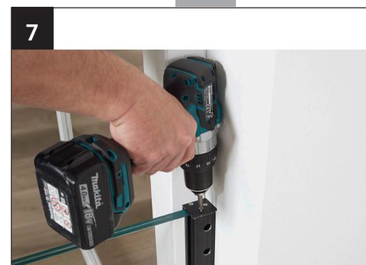
Schrauben Sie den mitgelieferten Zylinderstift mit der M4-Schraube im mittleren Bohrloch fest. Dieser Zylinderstift dient zur Sicherung der Glaslage. Die beiden äußeren Bohrlöcher sind für die Verbindung mit dem Profil.
