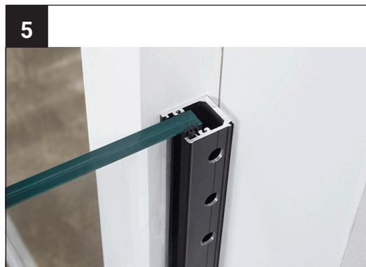
Achten Sie darauf, dass Sie den Glaseinstand im Profil auf beiden Seiten vermitteln. Jetzt fixieren Sie die Scheibe durch das eindrücken der inneren Klemmdichtung.
