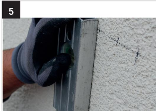
Zeichnen Sie mit Hilfe von Wasserwaage und Zollstock die vier Bohrlöcher der Schwerter an die Wand.
