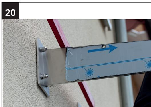
Richten Sie die Schwerter mit Hilfe der Wasserwaage bündig und lotgerade aus.
