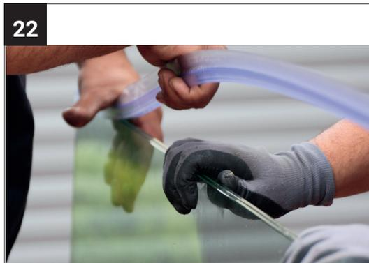
Sofern Sie eine Wandanschluss-Dichtung verwenden, schieben Sie diese nun aufs Glas.
