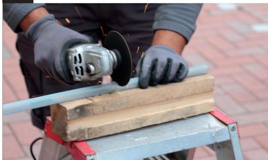
Schneiden Sie die Siebhülsen auf Länge der Bohrlöcher zu.
